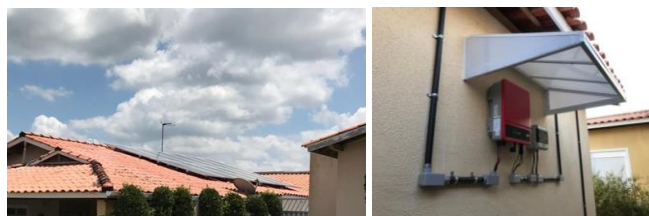
Fig. 6 Projeto das Instalações dos Módulos e Resultado final da Obra de Instalação
